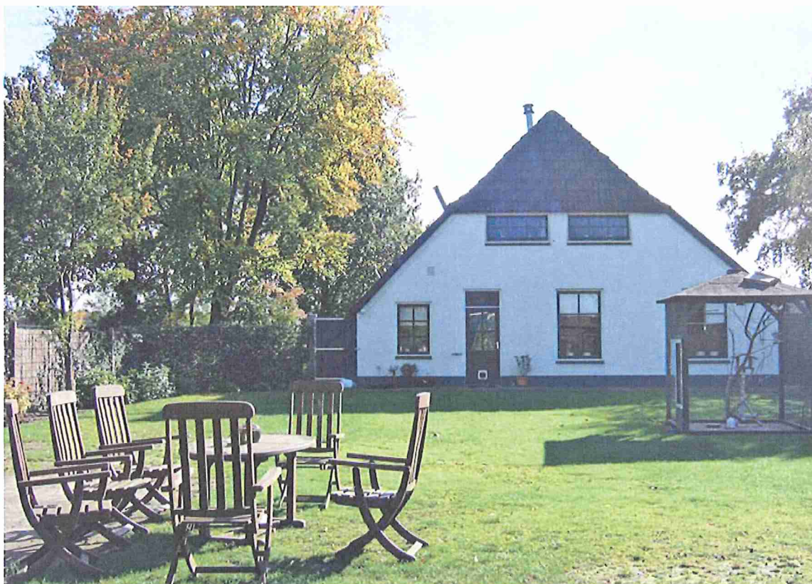
Achterzijde en tuin beheerderswoning
