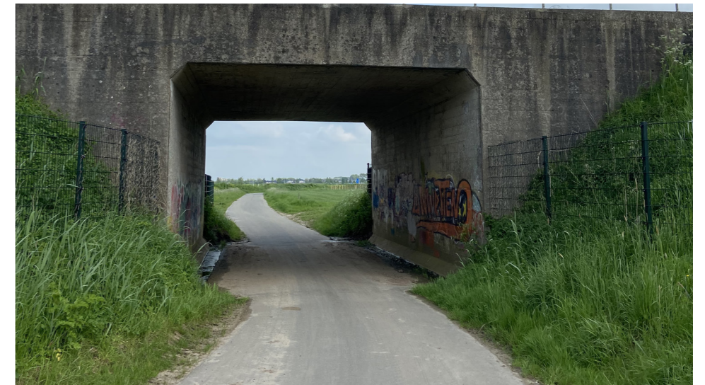
Onderdoorgang fietspad Tondense Enkpad en spoortalud
