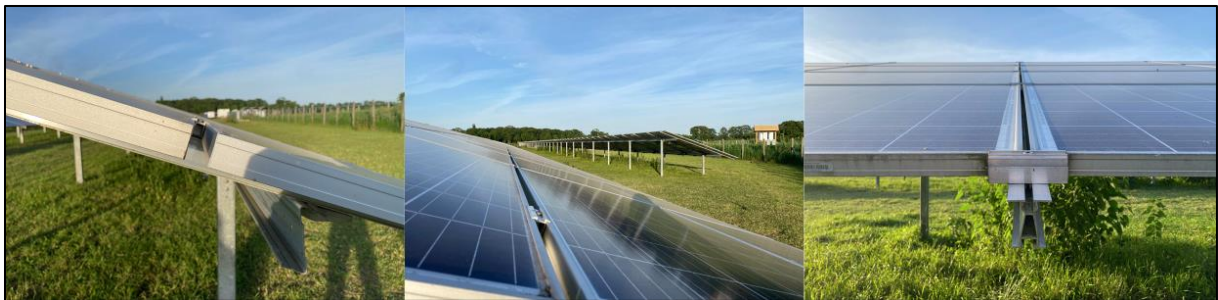
Figuur 23. Opstelling pv-panelen, waardoor voldoende ruimte is voor infiltratie regenwater (bron: Eelerwoude/TR).
