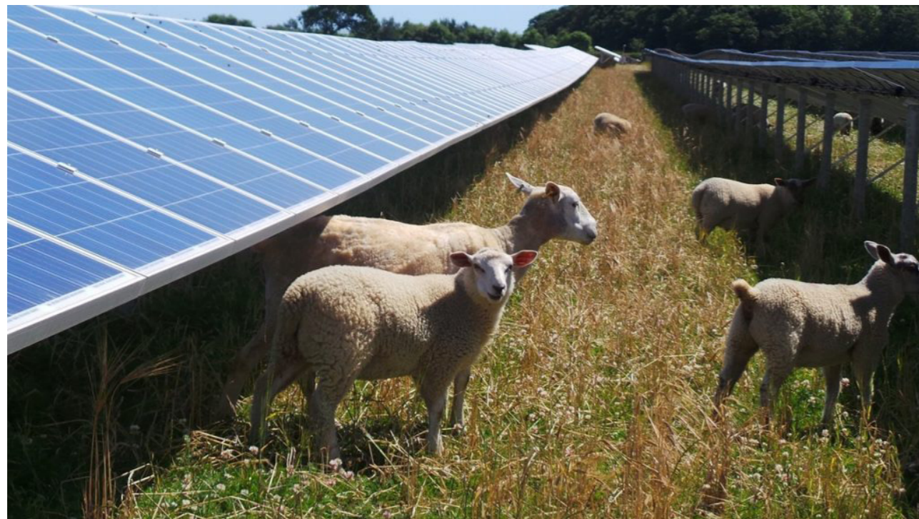
Bosmaaiër: laagste deel panelen en bij constructie
