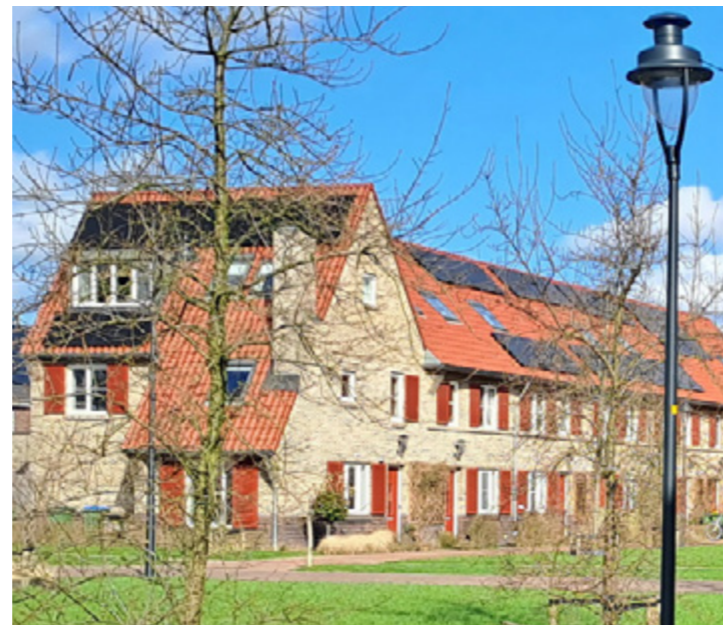
ongewenst: PV panelen doen afbreuk aan de architectuur
