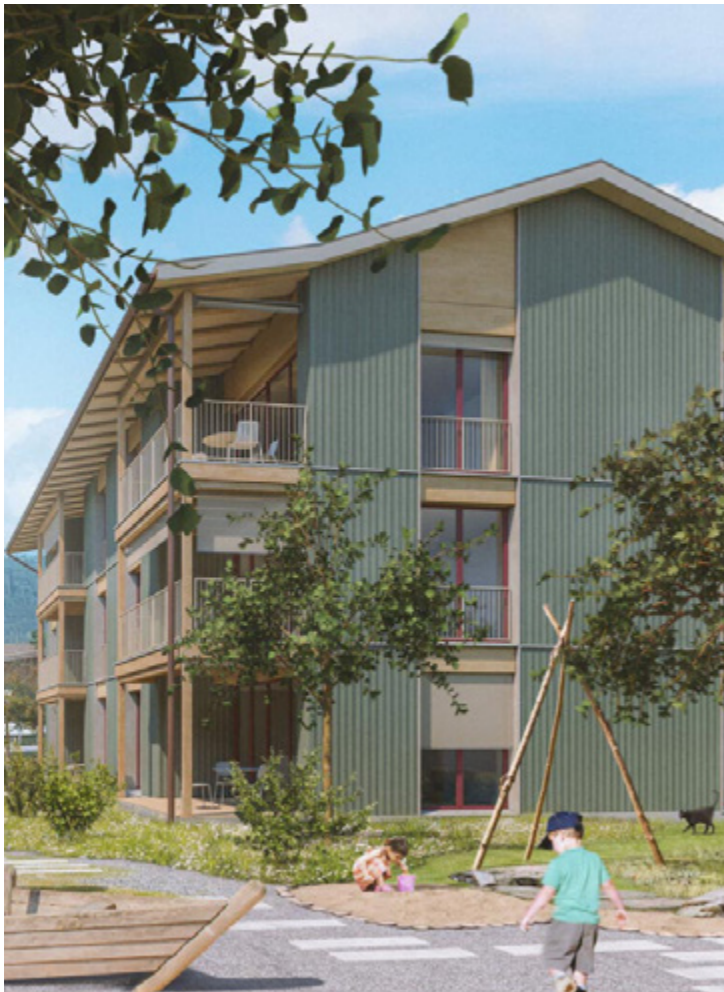
kopgevel met ramen (nb. deze gevelkleur is ongewenst)
