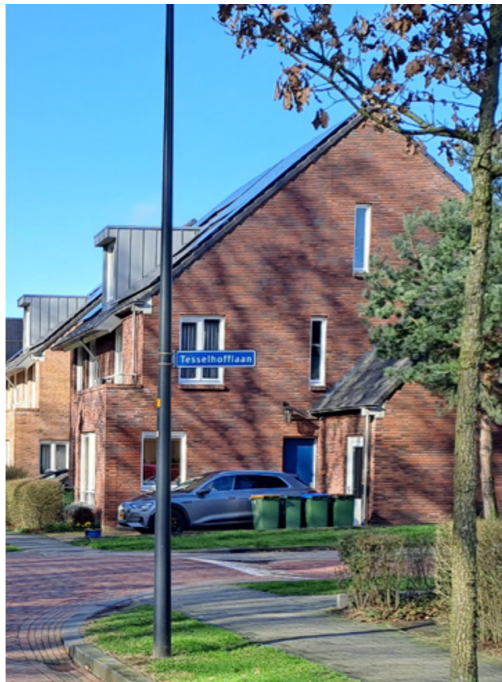
kopgevel met ramen en voordeur
