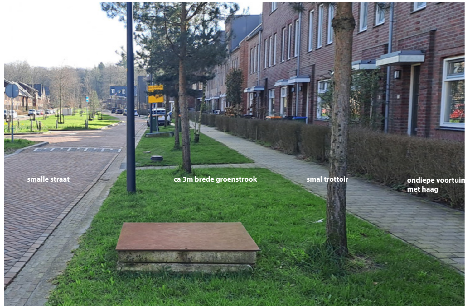
aan de zijde van de Louberweg komt een trottoir (referentiebeeld: ENKA terrein Ede)
