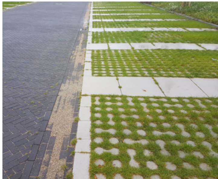
Parkeren op open grasbetonstenen ntb.: waterdoorlatend, minder hittestress, vriendelijk ogend.
