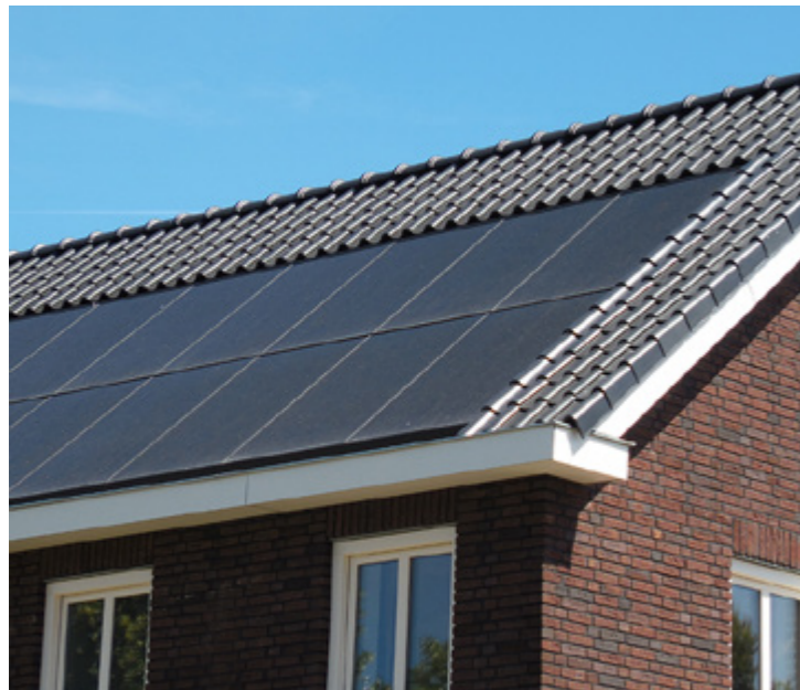
PV panelen zijn opgenomen in een dakvlak bestaande uit dakpannen
