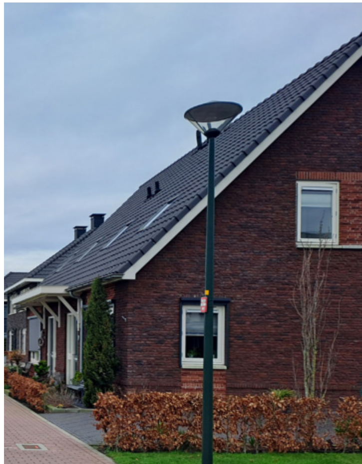
kopgevel gevelcompositie van verschillende materialen en ramen
