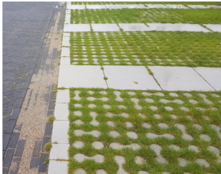
parkeren op opengras betonstenen: waterdoorlatend, minder hittestress, vriendelijk ogend
