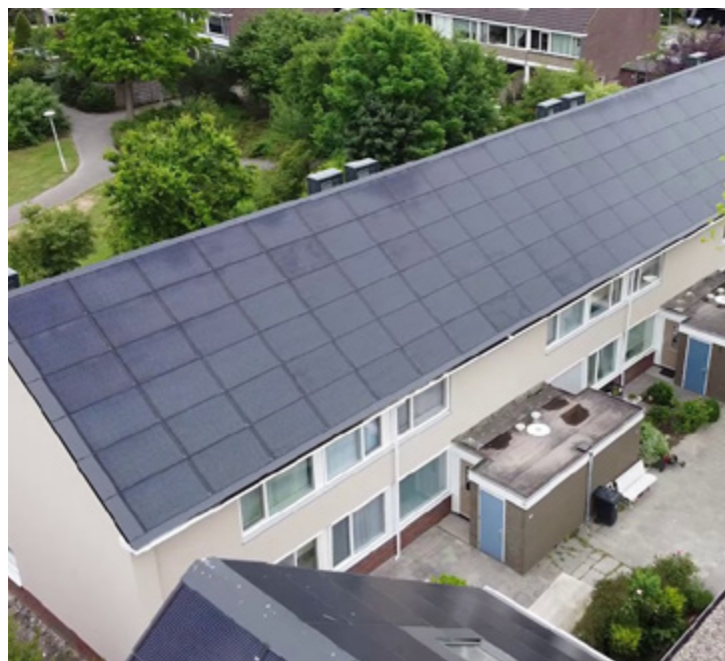
PV panelen beslaan het gehele dakvlak
