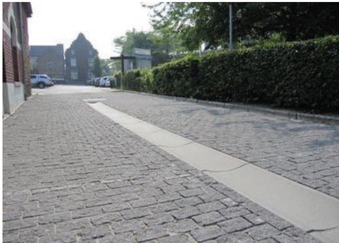
Gotensysteem in banden van het Elis Ligtleeplein
