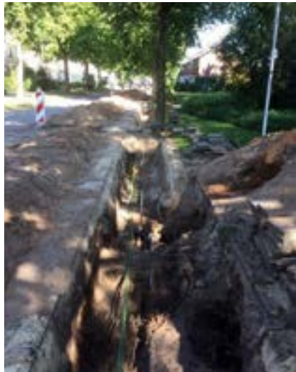
Afbeelding 7: kabels en leidingen in de bodem.
