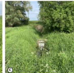
Schotbalhouw aan de oostkant van het plangebied in de Voorstondense beek
