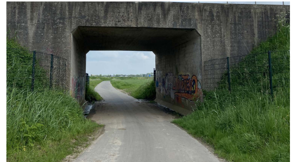
Onderdoorgang fietspad Tondense Enkpad en spoortalud
